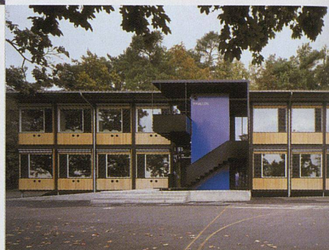
Beispiel für flexibles Bauen: Die provisorischen Schulpavillons sind ganz bewusst für eine begrenzte Lebensdauer konzipiert. Werden sie an einem Ort nicht mehr gebraucht, können sie problemlos auseinander genommen und zum nächsten Einsatzort transportiert werden.
