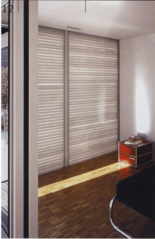
Detailansicht des GlassXcrystal-Elements. Neben seinen energetischen Funktionen sorgt es im Schlafzimmerbereich für Privatsphäre (siehe auch Titelbild).
