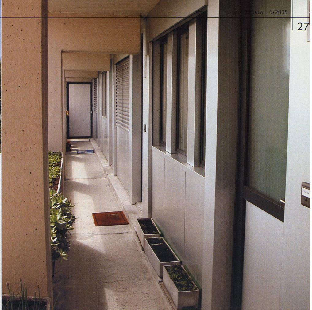
Auch auf der Eingangsseite mit den Laubengängen ersetzte man die gesamte Fensterfront. Keine Massnahmen waren beim angehängten unbeheizten Treppenhaus notwendig.
