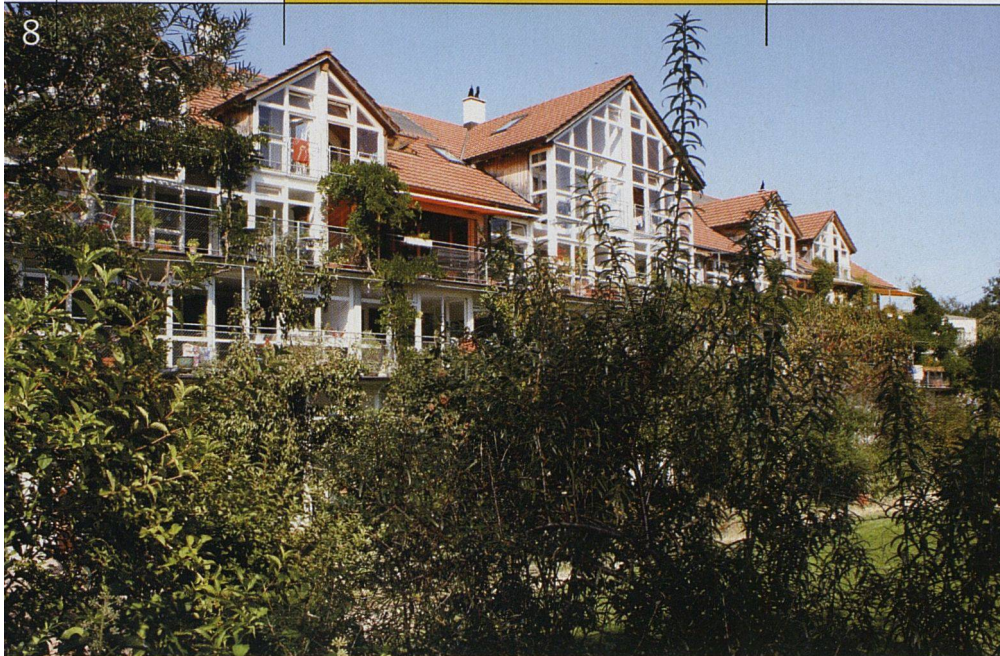
Ökologische Wogeno-Siedlung in Emmen: ein Holzofen im Wohnzimmer beheizt im Winter alle Räume.
