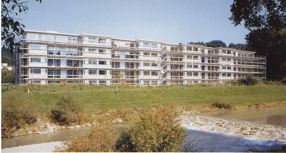
Dank grosszügiger Terrassen lässt sich die Aussichtslage geniessen. Der Grünraum gegen die Töss und der Spazierweg sollen als Auenlandschaft gestaltet werden.
