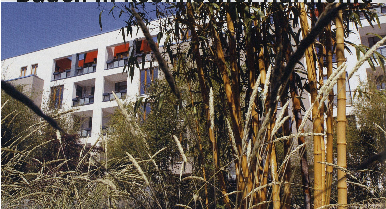
96 Wohnungen umfasst die nach Vasati-Prinzipien erstellte Siedlung der Wohnungsgenossenschaft Gartenheim in Hannover. Im Bild der Hof, dessen Bepflanzung das Fernostthema aufnimmt.
