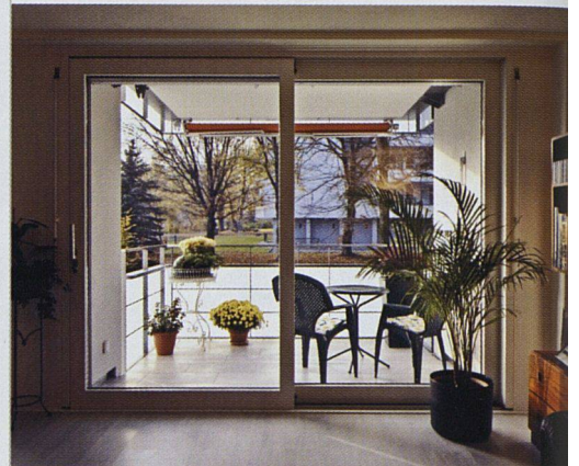
Dank den neuen Balkonen verfügen die Wohnzimmer nun über Panorama-Schiebefenster.
