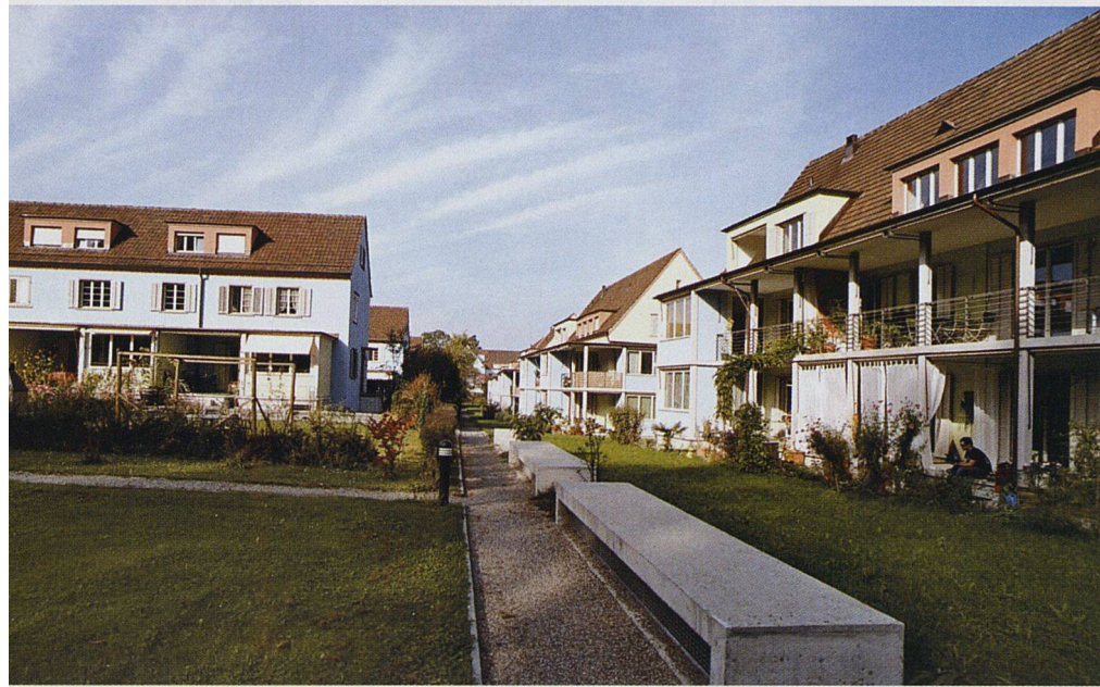
Besondere Sorgfalt galt dem Gartenstadtcharakter der Siedlung.
