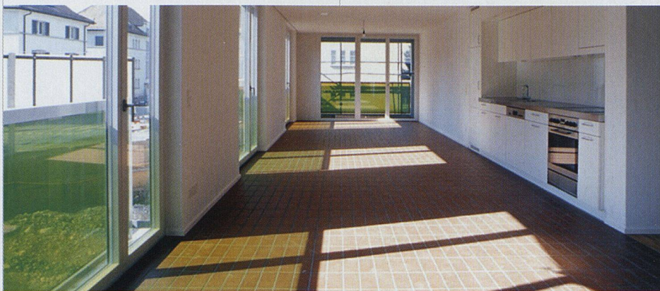
Praktisch unverwüster Klinker kommt bei der Neubausiedlung Werdwies der Stadt Zürich zum Einsatz. Bei diesem früher häufig verwendeten Belag handelt es sich um einen besonders stark gebrannten Backstein.
