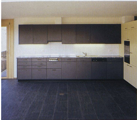
Die ASIG entschied sich bei den Wohnküchen in der Neubausiedlung Steinacker für Steinzeug. Die robusten Keramikplatten gleichen dem teureren Schiefer.
