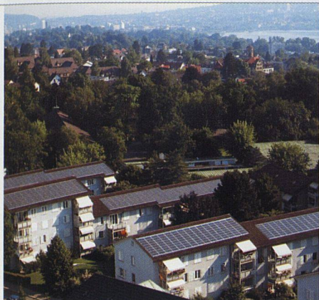
In der Siedlung «Im Moos» in Wollishofen hat sich die Fotovoltaikanlage zum Wahrzeichen entwickelt.
