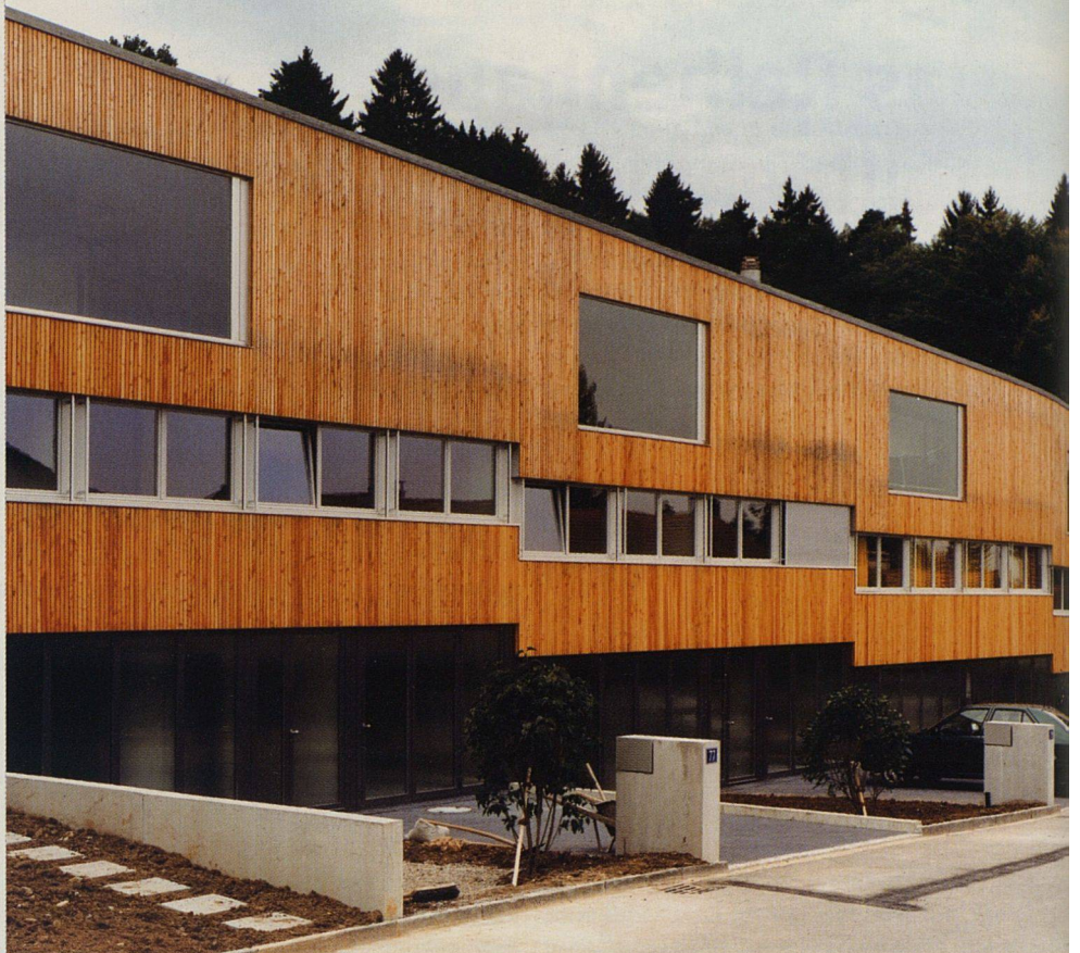
An der Rütihofstrasse in Winterthur erstellte Beat Rothen für eine private Bauherrschaft eine aussergewöhnliche Reihenhauseinheit.
