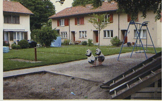
Am Kronwiesenweg werden wieder Reihenhäuser entstehen.
