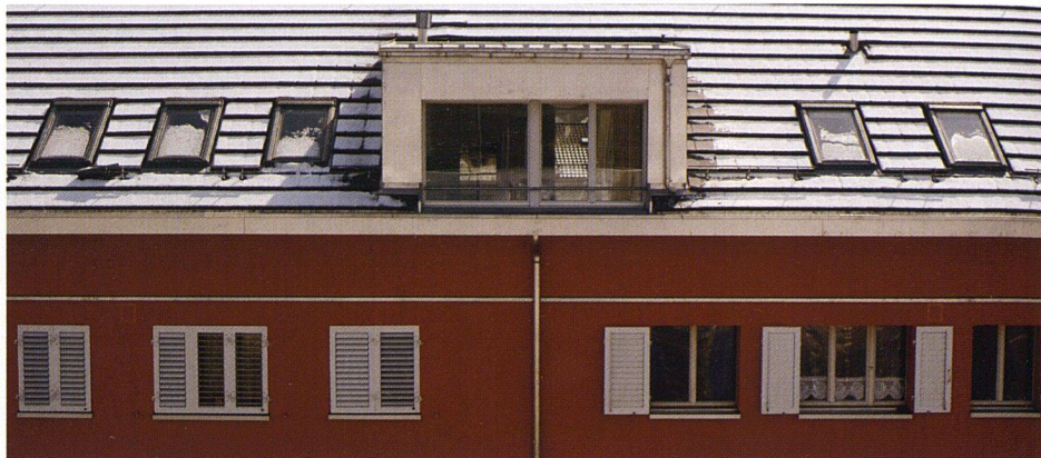
Das Erscheinungsbild veränderte sich durch das neue Dachgeschoss nur wenig.
