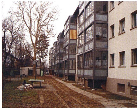
Beispiel eines beheizten Balkonanbaus: Im Rahmen der kompletten Sanierung der Mehrfamilienhäuser der Wohngenossenschaft Kaysersbergerstrasse in Basel wurden insgesamt 96 Balkone zu wohnraumerweiternden Wintergärten umgebaut (Architekt/GU: BfR AG; Unternehmer: Solarlux AG).
