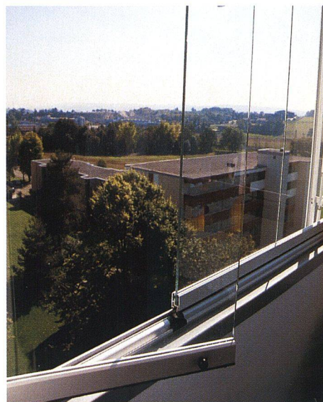
Dank Faltechnik kann diese Balkonverglasung an einem Hochhaus der Siedlungsgenossenschaft Luftverkehr (Silu) bei Bedarf ganz geöffnet werden.
