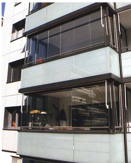
Die Wintergärten in dieser Siedlung der Baugenossenschaft Glattal lassen sich mittels Schiebelementen öffnen.
