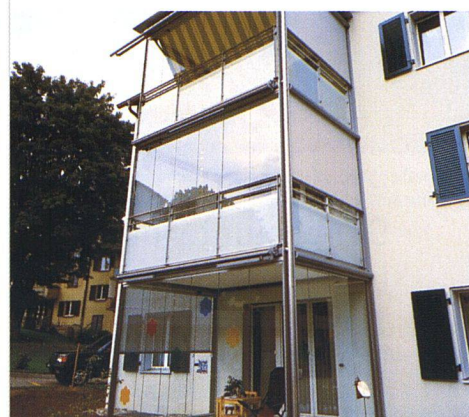
Die verglasten Balkone bzw. Sitzplätze können von Frühling bis Herbst genutzt werden.
