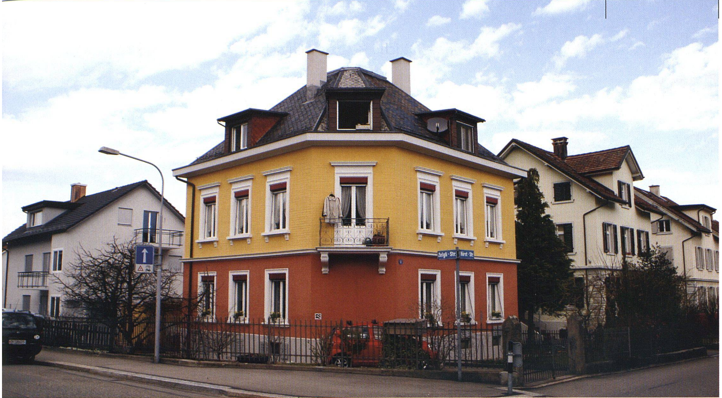
Das über hundert Jahre alte Haus an der Hürststrasse in Zürich Affoltern wird etappenweise renoviert.
