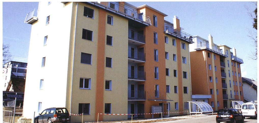
Ansicht der Strassenseite: ansprechendes Farbkonzept.
