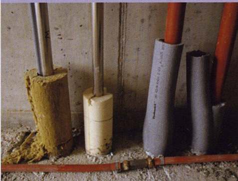
Siedlung Werdwies: Die bauökologischen Vorgaben erstrecken sich auf alle möglichen Materialien: Spanplatten, Farben, Kabelverkleidungen usw.
