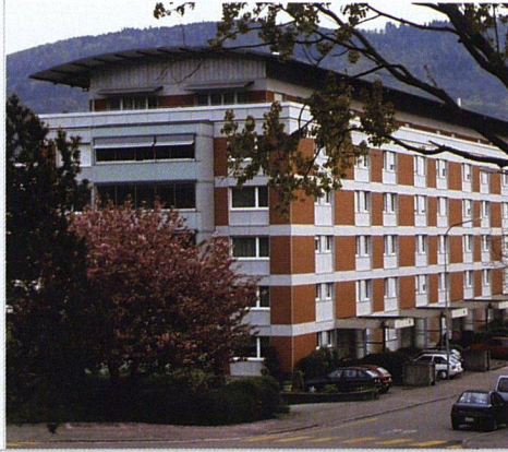
Auch die Bauten der Hochkonjunktur sind nicht unproblematisch: Die Siedlung der WBG Einfaches Wohnen benötigte nach zwanzig Jahren eine umfassende Sanierung; das Flachdach musste mit einer Kuppel überdeckt werden.
