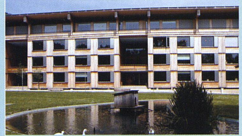
ökologische Baustoff der Zukunft. Renggli erstellt derzeit in Steinhausen ZG das erste sechsgeschossige Mehrfamilienhaus in Holzbauweise. (ri)
