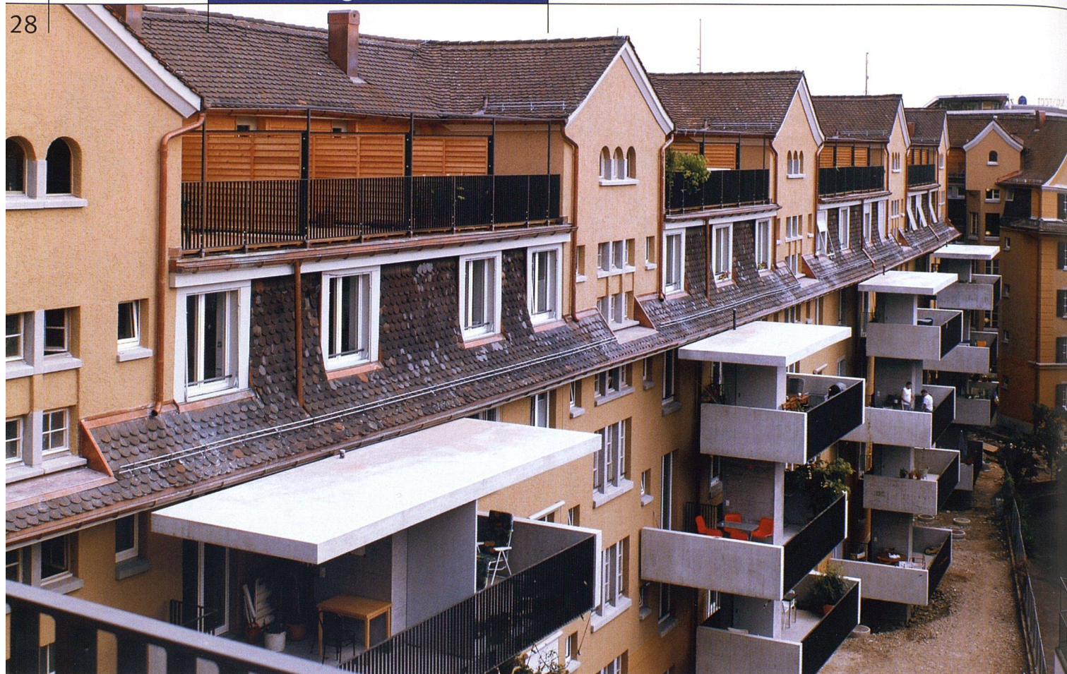
Blick in den Hof mit den neuen Balkontürmen und den individuellen Dachterrassen.
