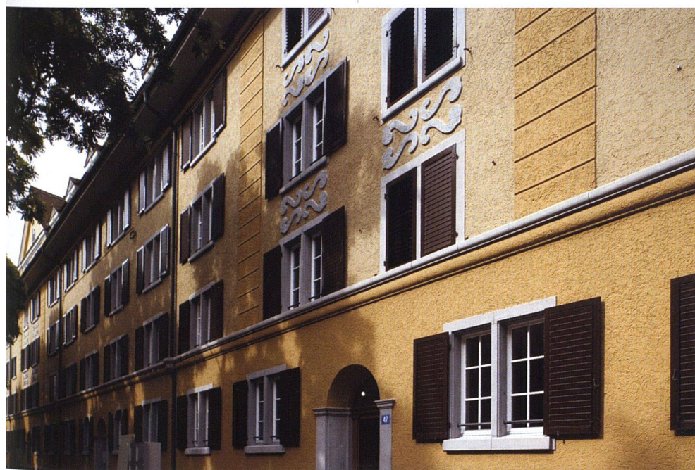
Die Fassaden gegen die Strassenseite durften nicht verändert werden.
