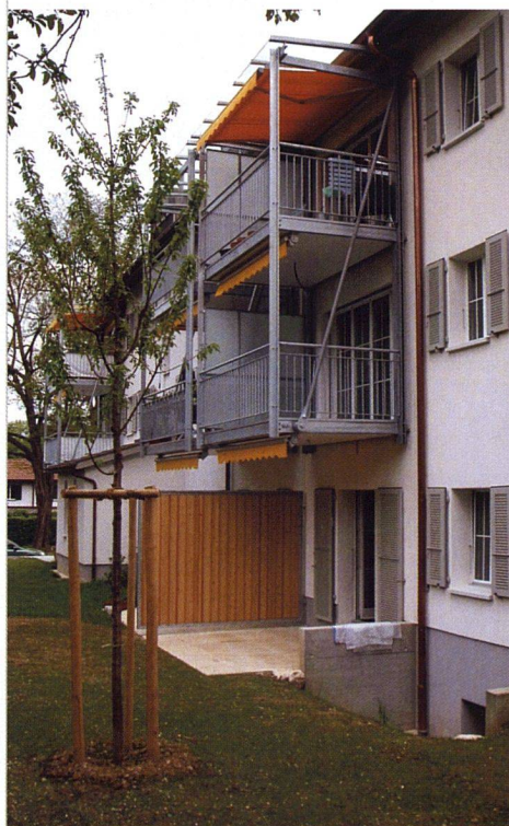
Die vorher in einer Nische versenkten Balkone wurden ganz nach aussen versetzt, so dass mehr Wohnfläche entstand. Die neuen Balkonkonstruktionen bieten zehn Quadratmeter Fläche. Wegen der Sonderbauvorschriften mussten sie über zwei Stockwerke aufgehängt werden.
