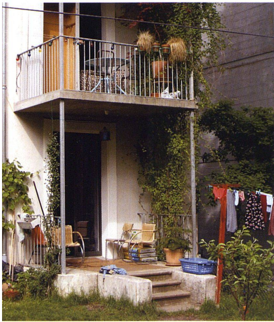
Blick auf die Gartenseite mit den neuen Balkonen.
