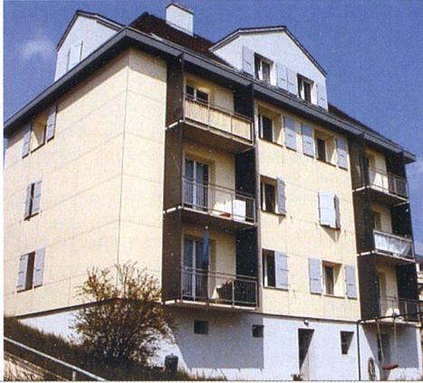
Das Mehrfamilienhaus «Bâtiment locatif» in Neuenburg wurde nach dem Minergie-Standard saniert. Die Energiebezugsfläche von 587 m 2 wird mit einer Gasfeuerung beheizt. Für eine solche Sanierung schüttet das Gebäudeprogramm der Stiftung Klimarappen einen Förderbetrag von rund 25 000 Franken aus.
