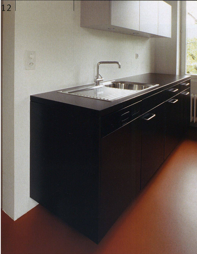
Echtholz oder Artefakt? Die Küchenzeile besteht aus braunem Kunstharz. Seitlich von der Wand weggerückt und auf Sockel gestellt, wirkt sie wie ein Möbelstück. Auch der Bodenbelag ist eine Holz-Camouflage: Er besteht aus Polyurethan.
