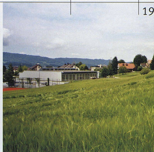
Auf diesem Areal will die Gemeinde Herrliberg durch die lokale Baugenossenschaft 36 preisgünstige Mietwohnungen bauen lassen. Diese sind an der teuren Zürcher «Goldküste» Mangelware.
