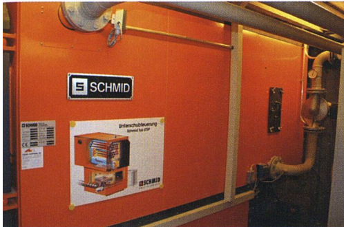
Die Pelletfeuerung erreicht eine Leistung von 300 kW.
