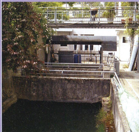
Das Kleinwasserkraftwerk der Siedlung Hard in Winterthur Wülflingen erzeugt Ökostrom für etwa 400 Haushalte.
