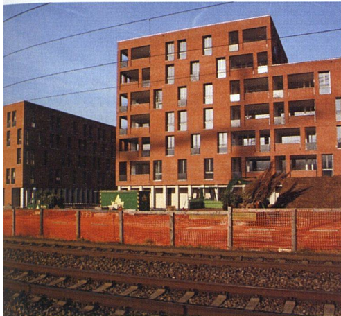
Die ABZ-Siedlung Ruggächern liegt an einer Bahnlinie. Aus Gründen des Schallschutzes ist eine doppelschalige Fassadenkonstruktion hier sinnvoll.
