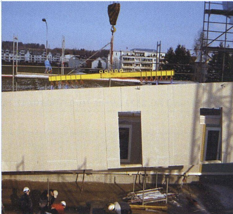
Fünf- bis siebenschichtige Massivholzplatten dienen als aussteifende Wände. Die Elemente wurden vorgefertigt geliefert und auf der Baustelle montiert.
