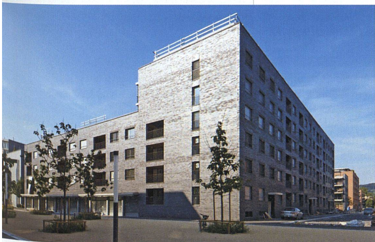
Klinkerfassaden prägen das Bild von der Strassenseite.
