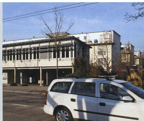
Ein parallel zur Hardturmstrasse angeordneter Büroriegel mit Läden und Restaurant schirmt die Siedlung Kraftwerk1 vor Lärmimmissionen ab. Die gleiche Lösung findet sich bei der Baugenossenschaft Waidmatt in Zürich Affoltern.
