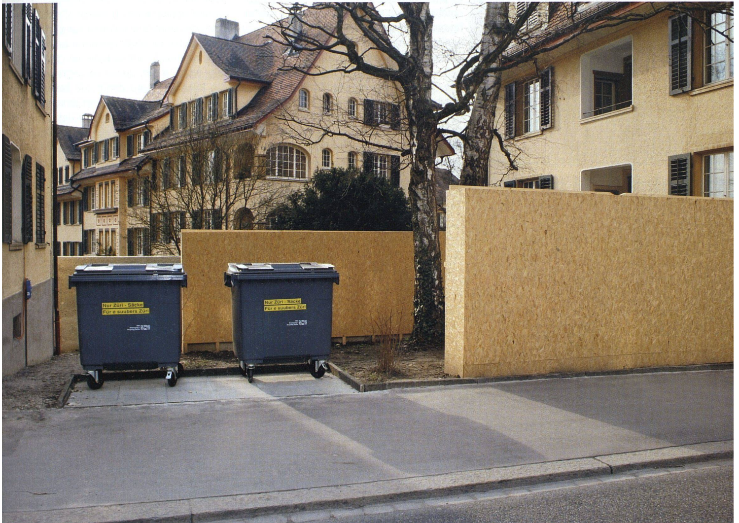
Mehrere versetzt angeordnete Scheiben schützen die Hofräume der städtischen Siedlung Riedtli in Zürich vor dem Verkehrslärm der Winterthurerstrasse.
