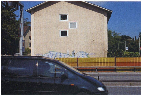
Lärmschutzwände sollen vor den schlimmsten Immissionen schützen – meist sind sie schlichtweg hässlich.
