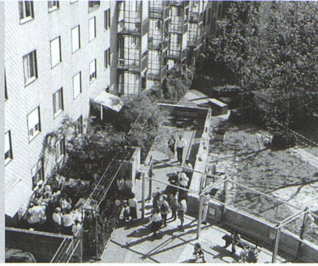
Das 1984 erstellte Wohn- und Geschäftshaus Manessehof (FGZ) ist ein frühes Beispiel für eine bauliche Lösung eines Lärmschutzproblems. Es präsentiert sich mit einer mehrheitlich geschlossenen Strassenfassade, die Laubengänge mit den Wohnungseingängen befinden sich hinter der äusseren Mauer. Die Wohnräume orientieren sich gegen den geschützten Hof.
