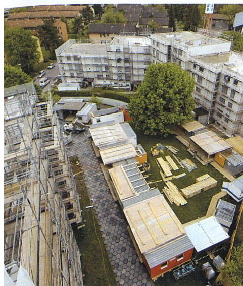
Foto: H.R. Berger Architekten AG
