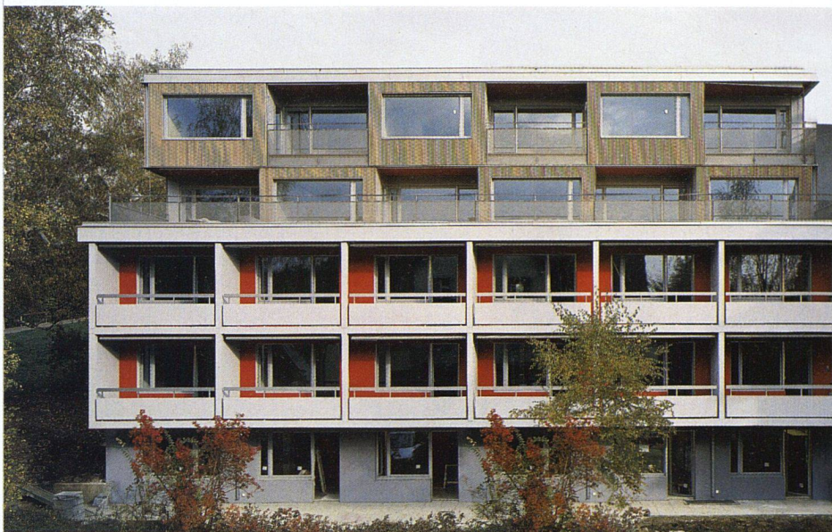
Bei der Siedlung Irchel schaffte die SAW mit Aufstöckungen mehr Platz.
