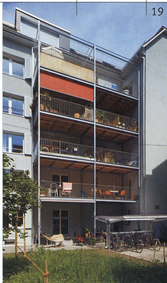
Die Wohnungen in den unteren Geschossen erhielten auf der Hofseite 20 Quadratmeter grosse neue Balkone.
