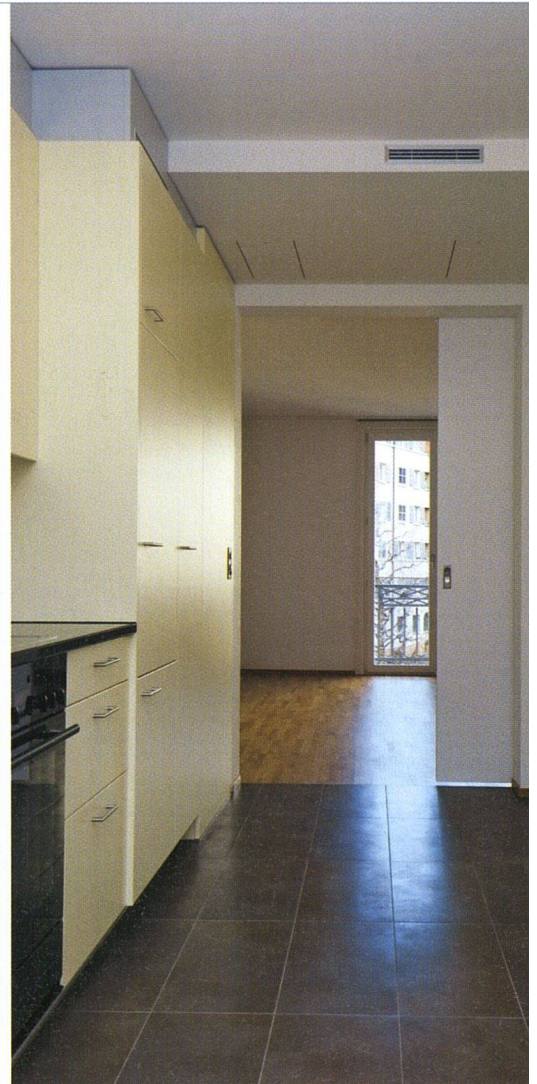
Die um die bisherigen Loggien erweiterten Küchen erhielten eine Öffnung zum Wohnraum. Dank Schiebetüren können sie jedoch auch geschlossen werden. An der Decke ist die kontrollierte Lüftung ersichtlich.
