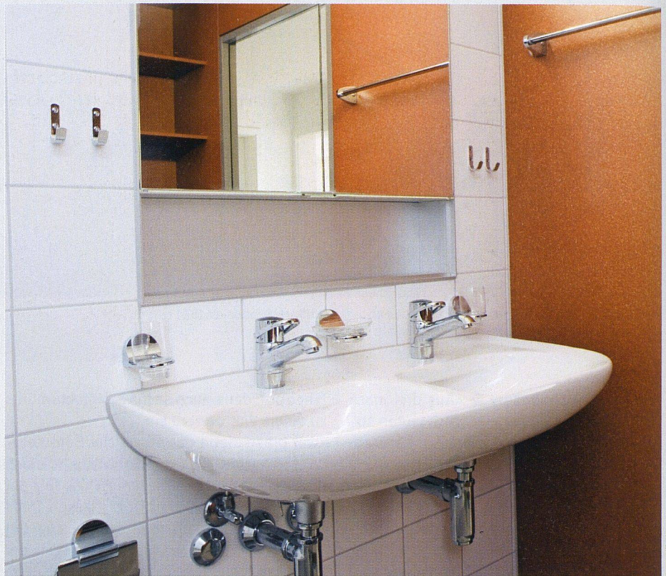
Die neuen Bäder: grosszügiges Doppellavabo und moderne Materialien.
