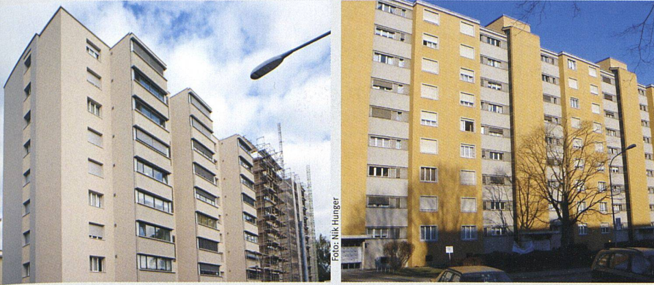
Die neuen Anbauten greifen nicht allzu stark in die bisherige Optik der Fassade ein (Bild rechts), sondern verstärken das vorhandene Relief einfach in der Tiefe.
