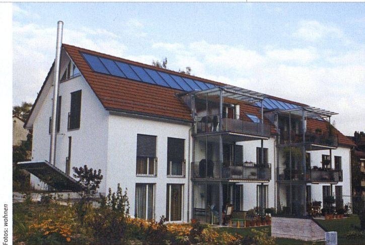
Eines der vier Mehrfamilienhäuser der WGW-Siedlung Haspel in Kollbrunn. Solarkollektoren auf dem Dach sind Teil der ökologisch vorbildlichen Wärmeversorgung.
