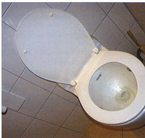
Eine Vakuumtoilette für Privatwohnungen unterscheidet sich optisch und vom Komfort nicht von einer konventionellen WC-Schüssel.
