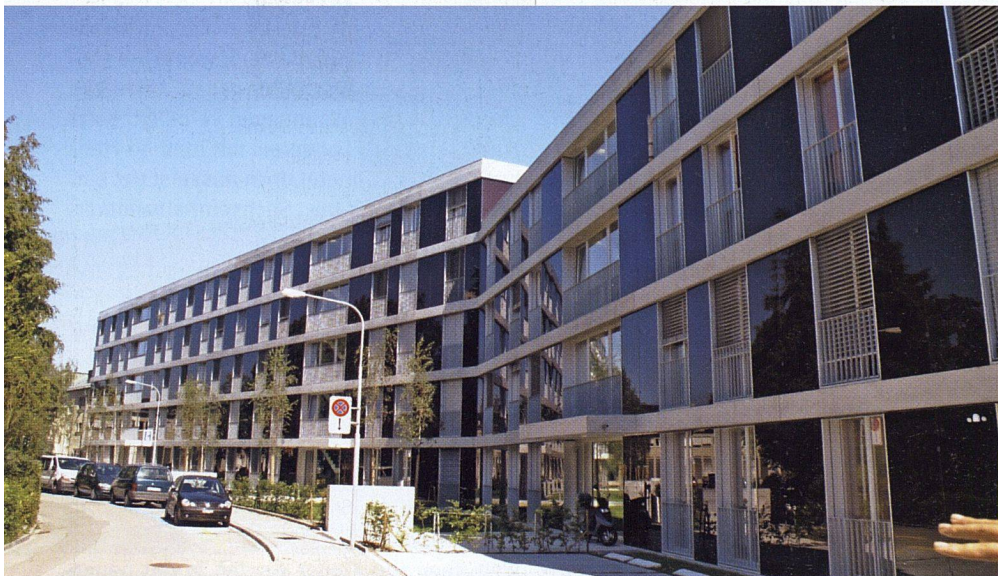
Auf den Strassenseiten, wo sich die Hauseingänge befinden, besitzen die Bauten schlichere Farben.
