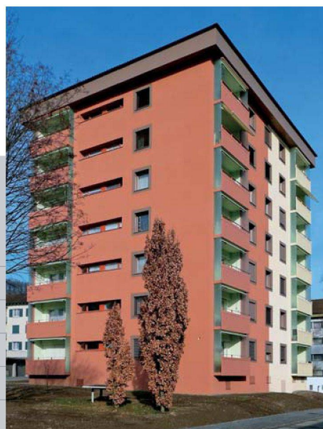
Die neue Kompaktfassade bietet zeitgemässen Wärmeschutz.
