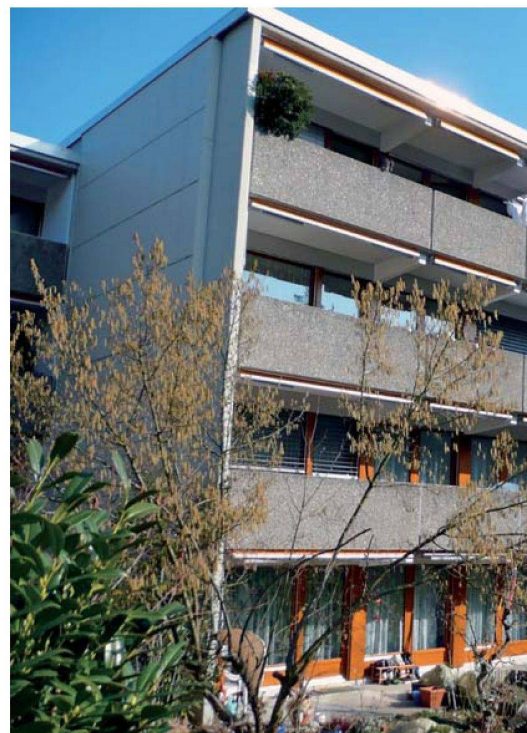
Blick auf die Balkonseite.
