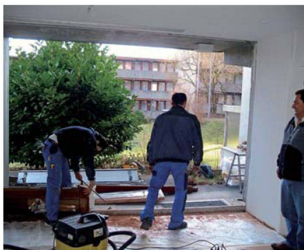
Die Fenster wurden als Module angeliefert und mussten innert einem Tag eingesetzt werden.
