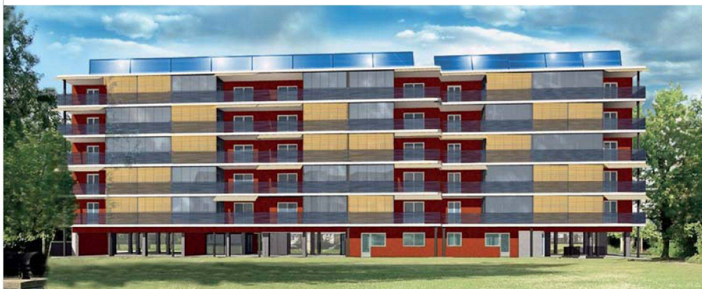
Die Baugenossenschaft zum Stab in MuttENZ erneuert eine Siedlung mit hundert Wohnungen nach Minergie. Dabei baut sie auch Sonnenkollektoren ein.
