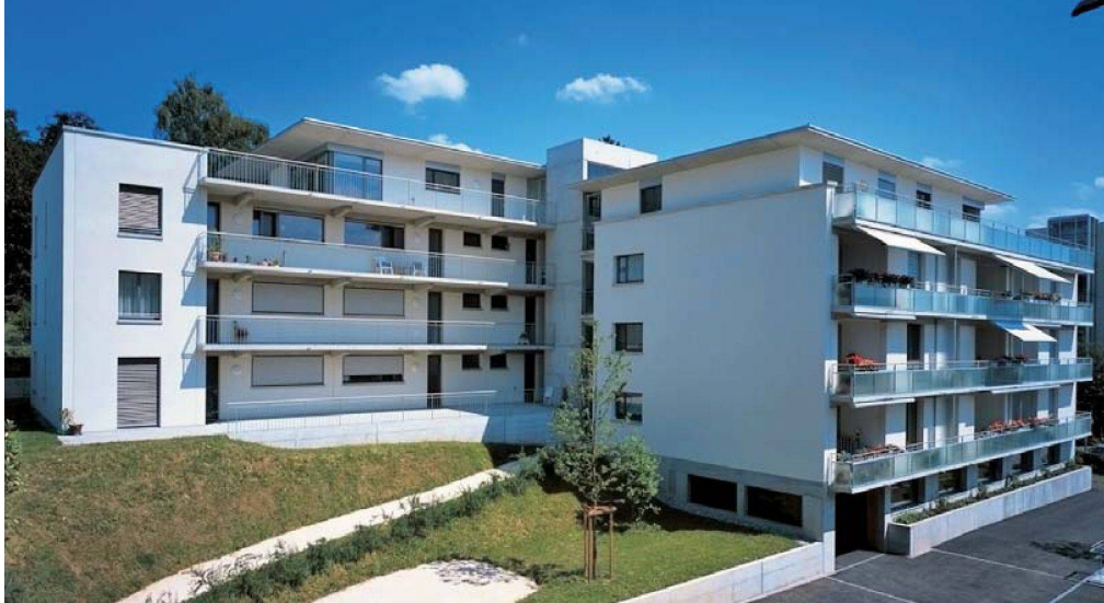
Die Senioren-genossenschaft Waldeck in Binningen konnte 2002 dank einer Bürgschaft 34 Wohnungen errichten. Derzeit ist die zweite Etappe im Bau. Im Bild die erste Etappe, entworfen und ausgeführt von der Basler Atelieregemeinschaft Hanspeter Müller & Roland Naegelin, Architekten BSA.
