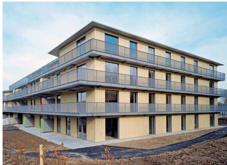
Die Fassadenverschalung aus gelb gestrichenen Holzplatten sowie die rundum laufenden Balkone prägen die Bauten.
