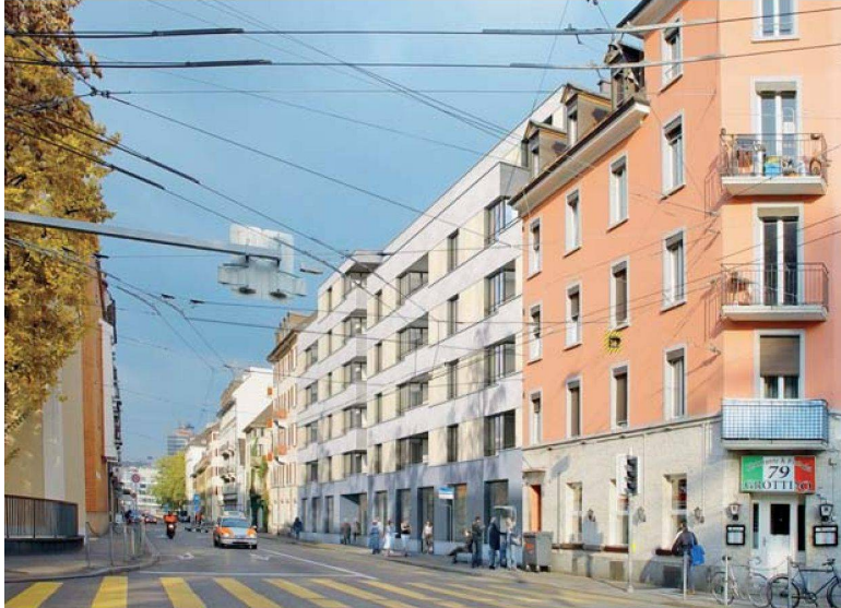
35 Wohnungen sowie Büroräumlichkeiten für die SAH entstehen an der Feldstrasse. Das Projekt stammt von Durrer Linggi Architekten AG.
