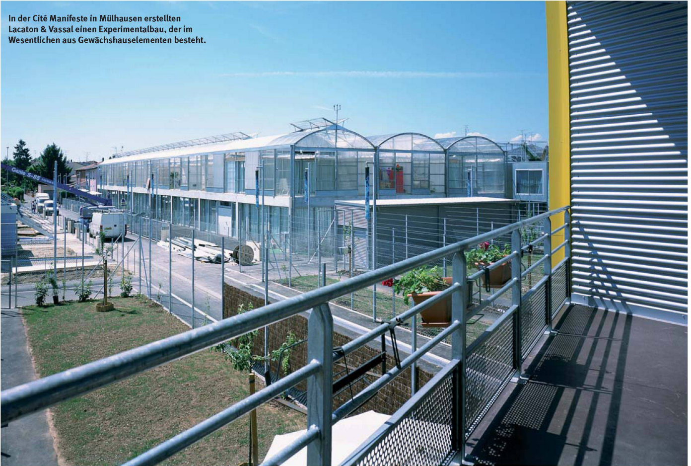
Offene Strukturen bestimmen die Wohnungen. Mit dem Rohbeton und den Stützen in der Wohnung gemahnen sie an Gewerbebauten.
