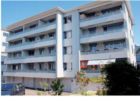
Bei der Totalsanierung ihrer Siedlung Büelhofstrasse wagte die Baugenossenschaft Allmend in Winterthur erstmals den Schritt zu Minergie.
