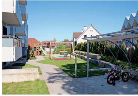
An der Siedlung Büelhofstrasse wurden auch die Balkonbrüstungen erhöht und der Aussenbereich neu gestaltet.
