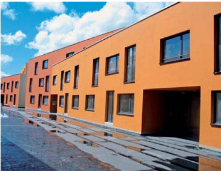
Über 300 Wohnungen wird das neue Quartier Weissenstein schon im laufenden Jahr umfassen; mit dem Projekt Hardegg (rechts), das 120 Miet- und 66 Eigentumswohnungen bietet, ist auch hier die Baugenossenschaft Brünnen-Eichholz dabei.
