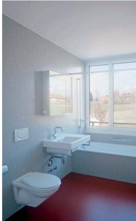
Bad in einer Viereinhalbzimmerwohnung: Die in starken Farben gehaltenen Böden aus PU kontrastieren mit den weissen Wannen und Becken sowie den hellgrauen Mosaikfliesen.
