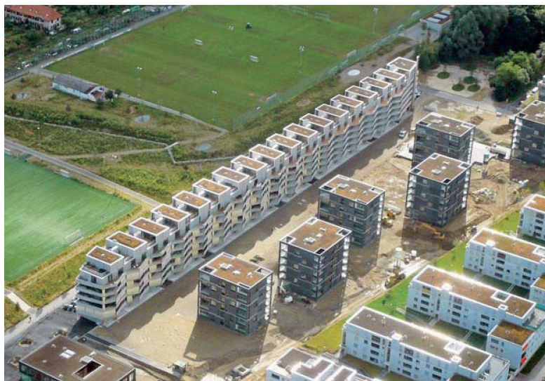
Gesamtanlage: Das Langhaus erstreckt sich entlang von Sportplätzen und Grünflächen. In den sechs Punkthäusern sind die Eigentumswohnungen untergebracht.
