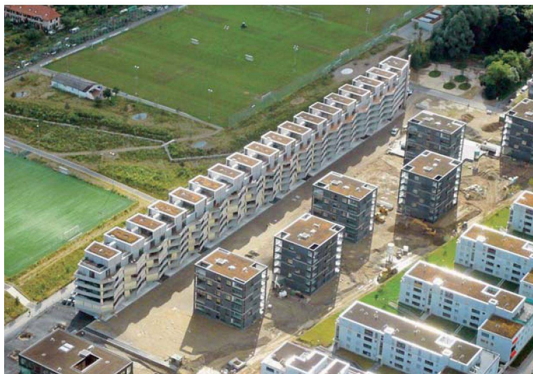
Gesamtanlage: Das Langhaus erstreckt sich entlang von Sportplätzen und Grünflächen. In den sechs Punkthäusern sind die Eigentumswohnungen untergebracht.
